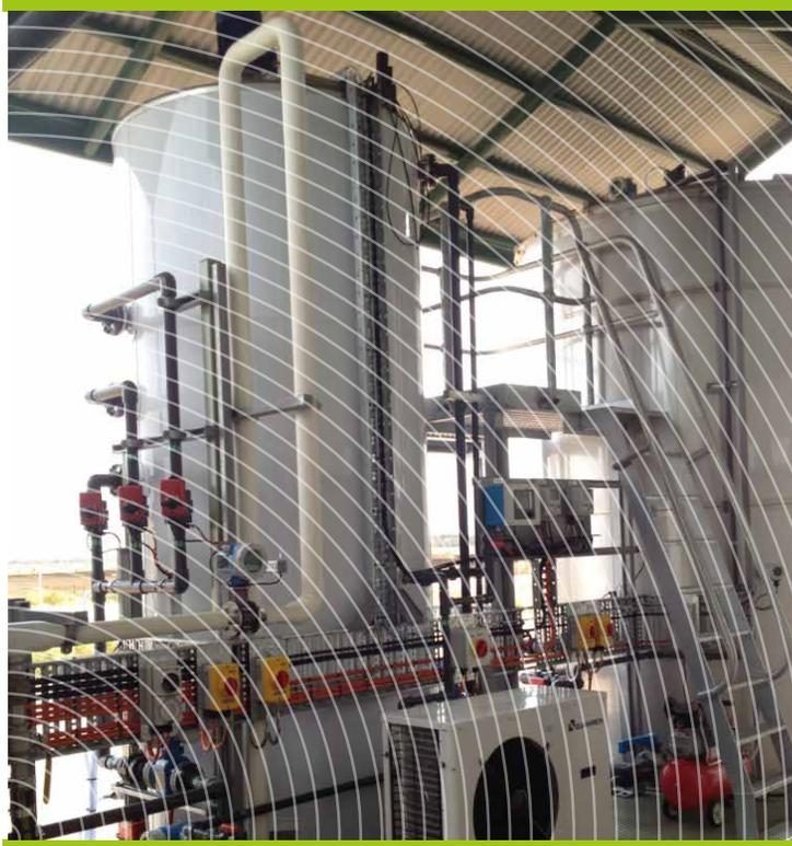
elimina el nitrógeno generado en la digestión anaerobia de fangos
