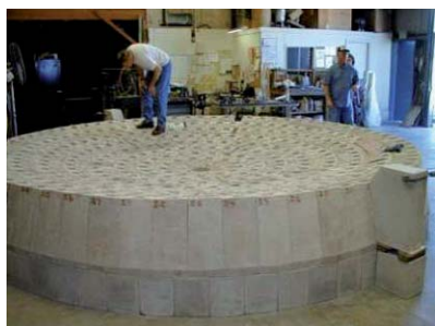
Figura 6. Pre montaje del arco-bóveda que contiene las toberas
