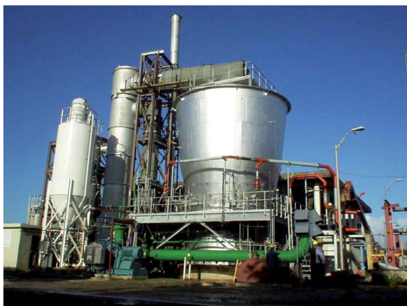
Figura 3a. Instalación de incineración de lodos en Puerto Rico – 1 x 2415 kg MS/h
