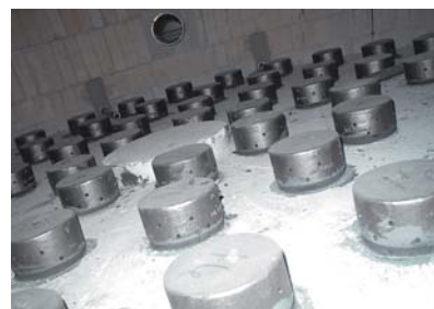
Figura 7. Detalle de la distribución de las toberas
