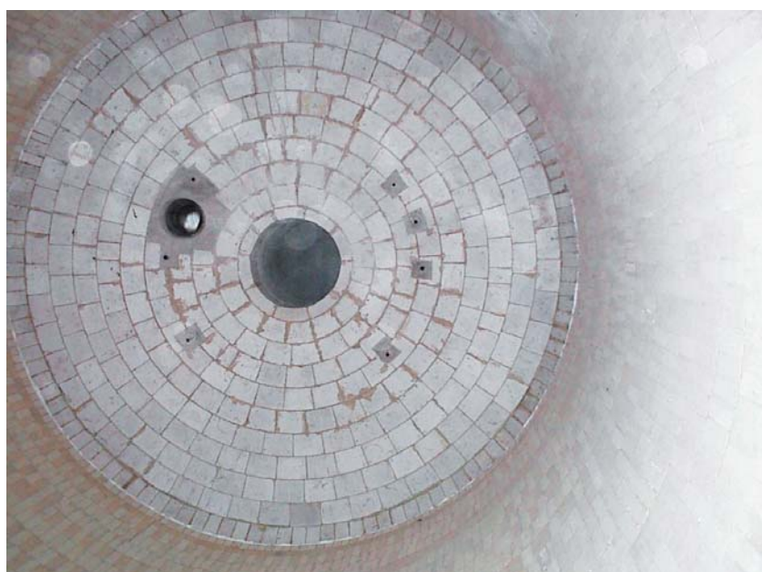
Figura 11. Cúpula refractaria auto portante del horno
