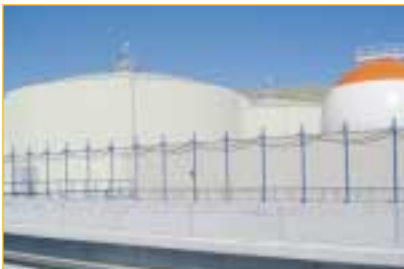
• DIGESTORES LA GAVIA.
