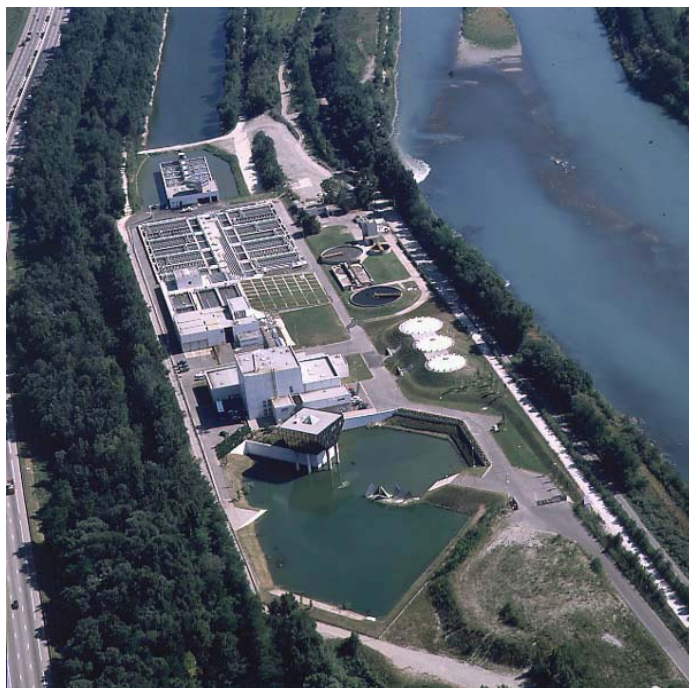
EDAR Grenoble (Francia)
