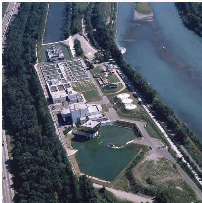
EDAR Grenoble (Francia)
